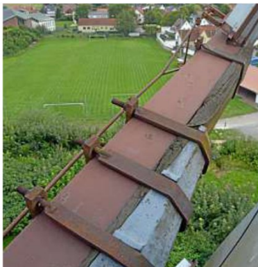
Die Trockenheit im Sommer 2022 sorgt für Probleme bei der Befestigung der Flügel am fünfarmigen, gusseisernen Drehkreuz, dem so genannten Rosettenwellkopf, einem in England gefertigten Originalteil der Mühlenantriebstechnik.
