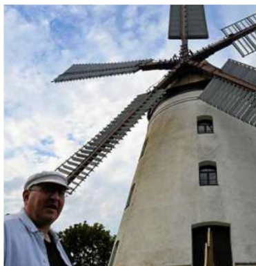
Die fünfzügige Holländer-Windmühle, erbaut 1837. Trockenheit im Sommer 2022 sorgte für Probleme bei der Befestigung der Flügel. Thorsten Geschke, stellvertretender Vorsitzender des Mühlenfördervereins, erklärte die Reparaturmaßnahme.
