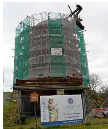
Bei der Komplettanierung 2014/15 erhielt die Mühle unter anderem einen neuen Außenputz.
