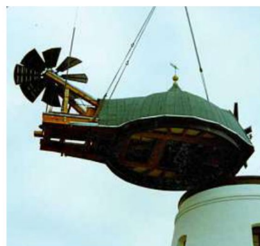
Die Mühle in Wendhausen bei den Sanierungsarbeiten 2003. Per Kran wurde die Kappe auf den Turm gesetzt.
