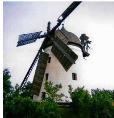
1994 ist die Mühle Wendhausen bei einem Sturm schwer beschädigt worden.
